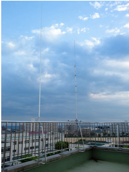
図 3. 設置した GP アンテナ
